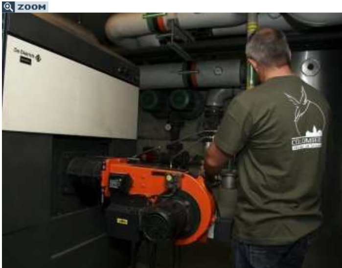
Une chaudière écologique et économique installée par la ville de Colomiers. Photo DDM..
